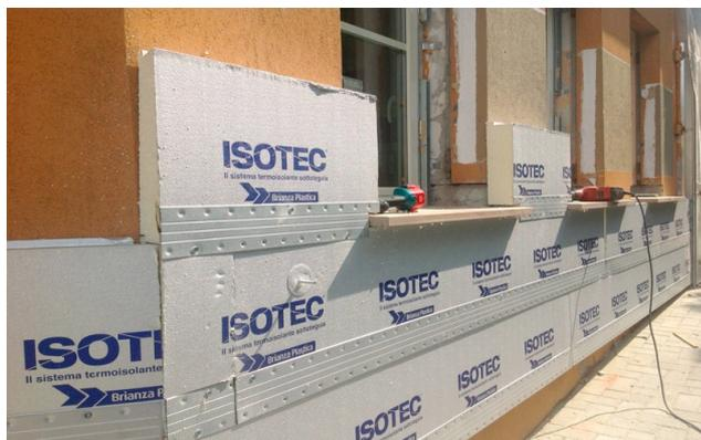
**ISOTEC LINEA** è un sistema di isolamento termico in poliuretano espanso rigido progettato per isolare coperture e facciate non ventilate rivestite con materiali metallici, adatto sia per il recupero di tetti di costruzioni già esistenti sia per nuove costruzioni.
