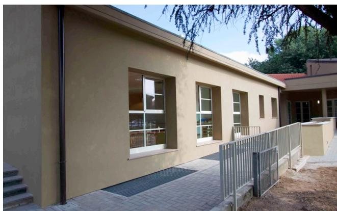
L'edificio, realizzato agli inizi degli anni Ottanta, si sviluppa su due livelli (un piano seminterrato e un piano terra) e ha una struttura portante mista, composta da un telaio in cemento armato con pilastri, setti e travi, da una muratura portante in mattoni e da un solaio in laterizio gettato in opera.
